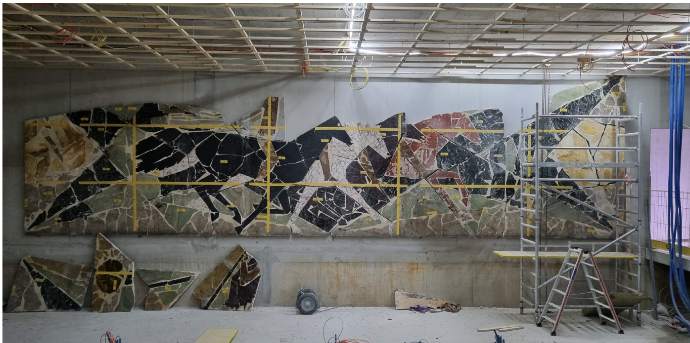
Réinstallation des Amazones de Jacek Stryjenski dans l'aula de la caserne d'Avully. Crédit photo : FCAC
