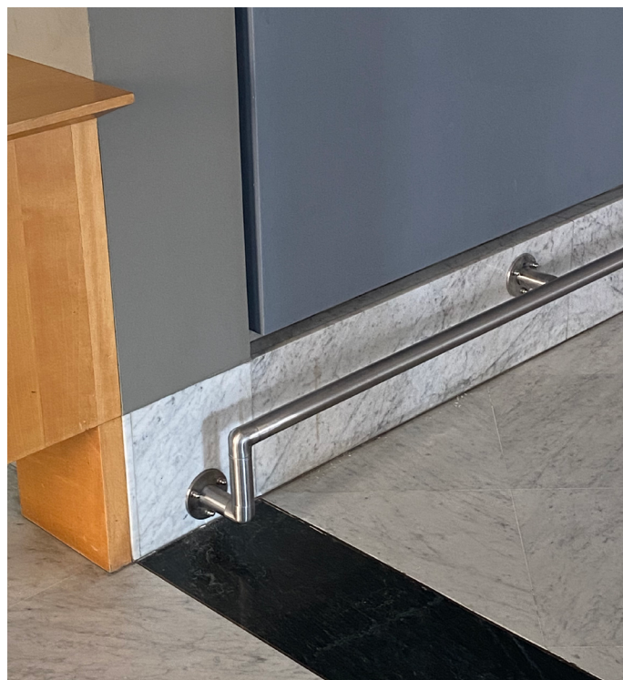
Vue sur l'écarteur installé sous les panneaux de Paul Viaccoz. © FCAC
